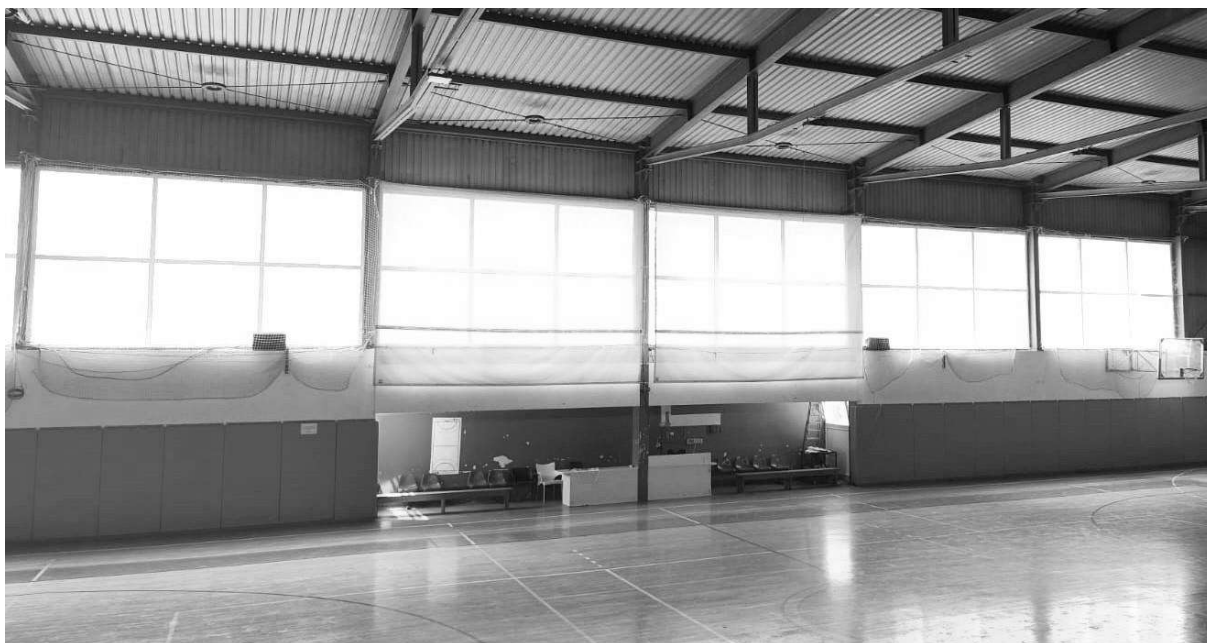
Slika br: 20 Postavljena 2 screen platna za zaštitu staklene stijene u dvorani ŠRC-a Mocire
