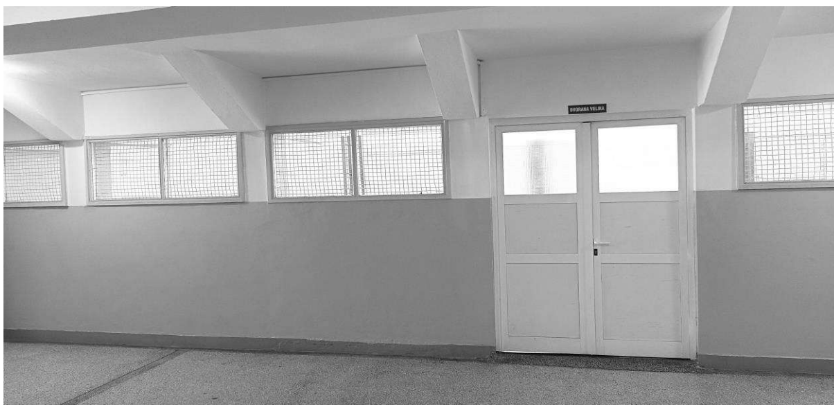
Slika br. 11 Soboslikarski radovi u glavnom hodniku dvorane ŠRC-a Ravnice (1)
