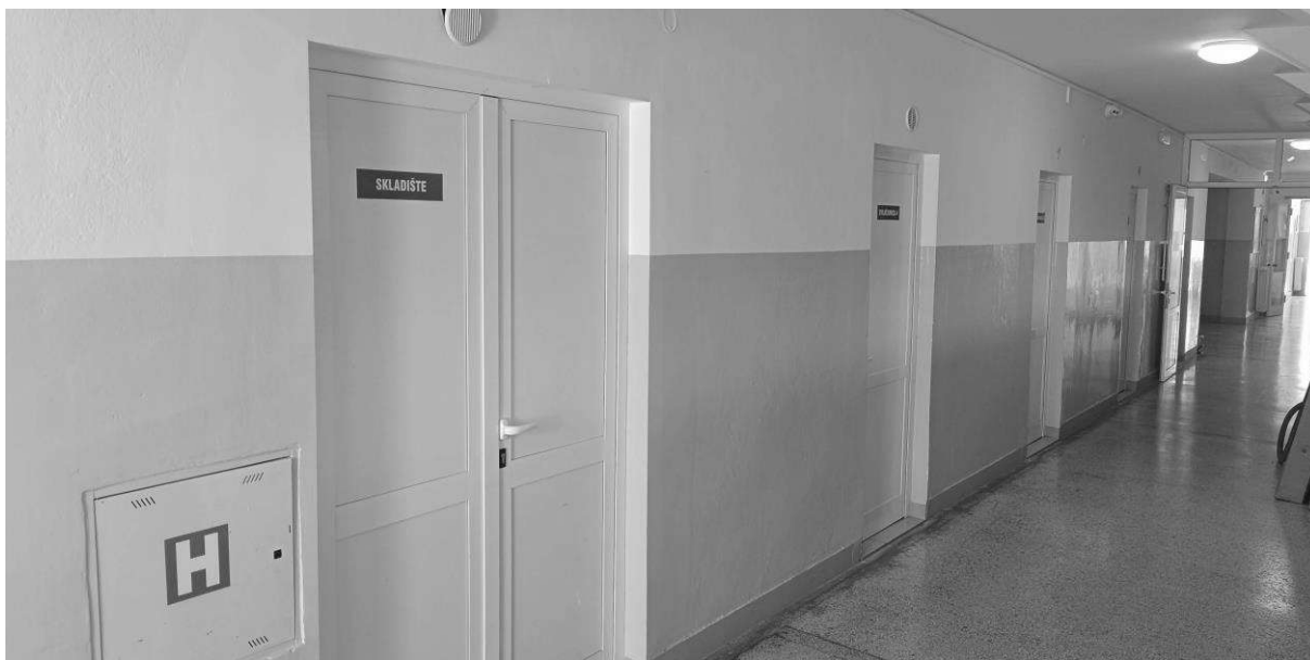
Slika br. 12 Soboslikarski radovi u glavnom hodniku dvorane ŠRC-a Ravnice (2)
