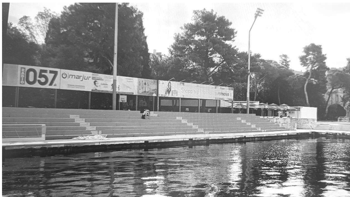
Slika br. 26 Obojane tribine i željezna ograde uz bazen Otvorenog plivališta Kolovare
