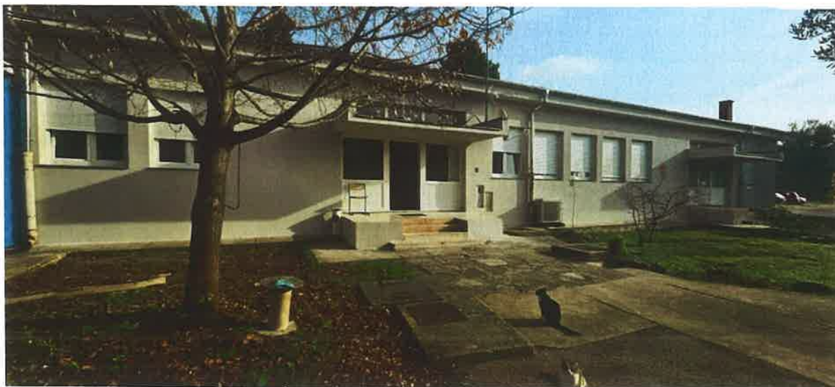
Fasada VP Gaženica nakon obnove
