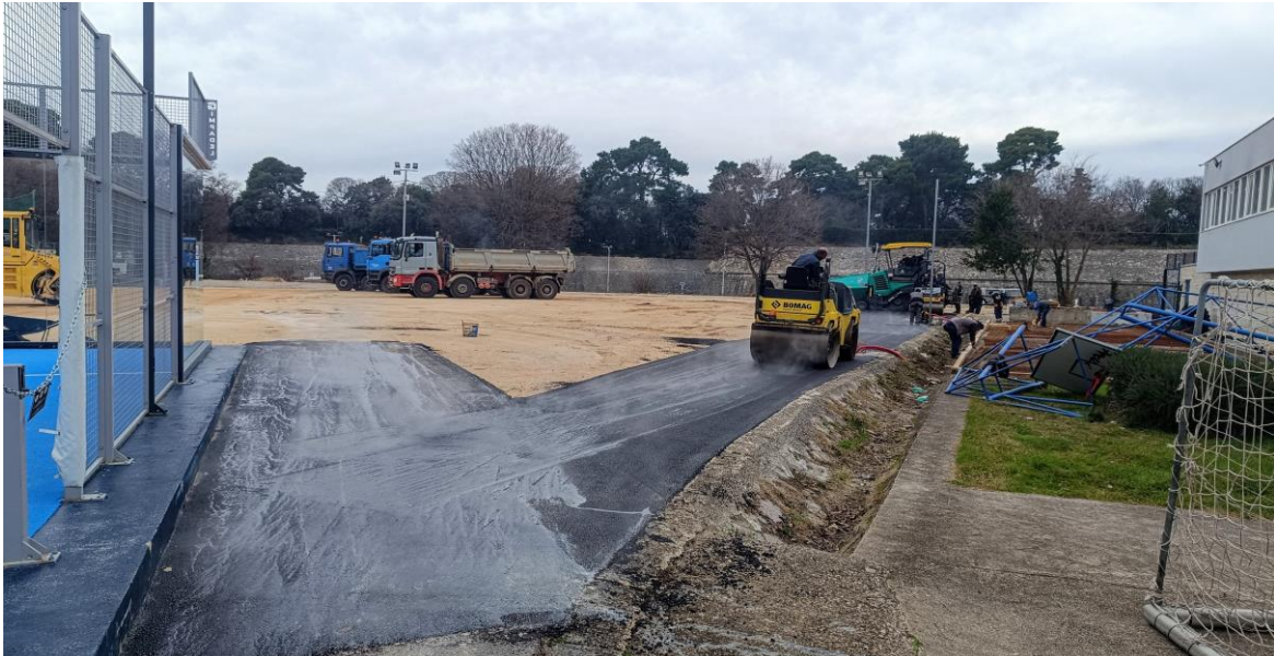
Slika broj 11: Asfalterski radovi na vanjskim terenima ŠRC-a Ravnice
