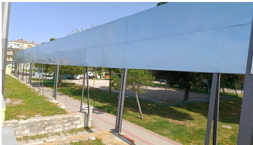
Slika broj 32: Sanirana čelična konstrukcija reklamnih panoa na Otvorenom plivalištu
