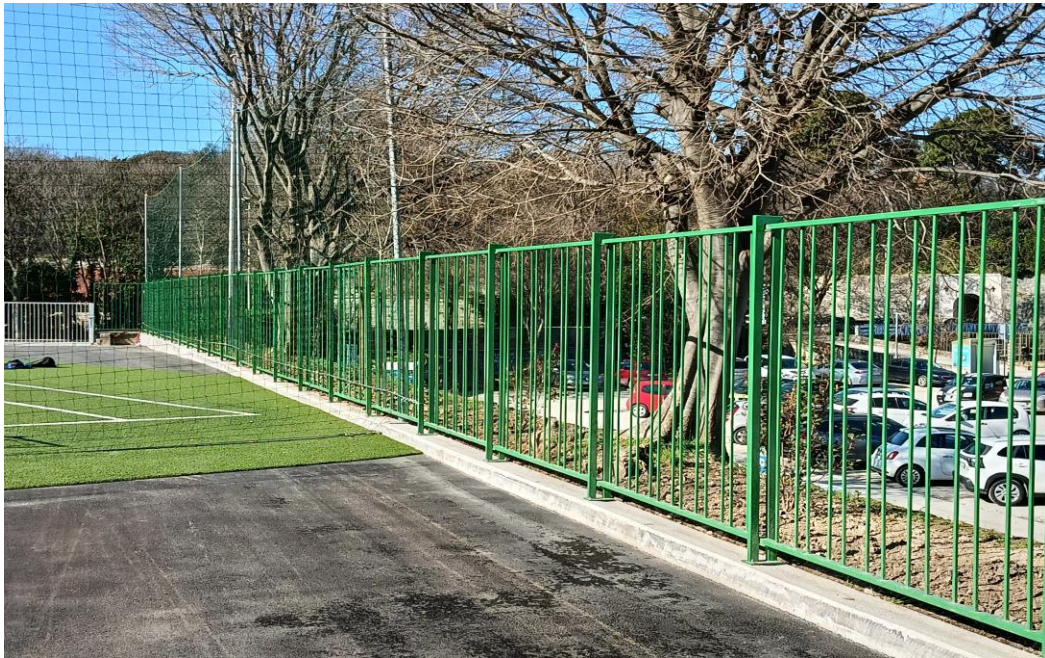
Slika broj 13: Postavljena metalna ograda vanjskog sportskog igrališta ŠRC Ravnice
