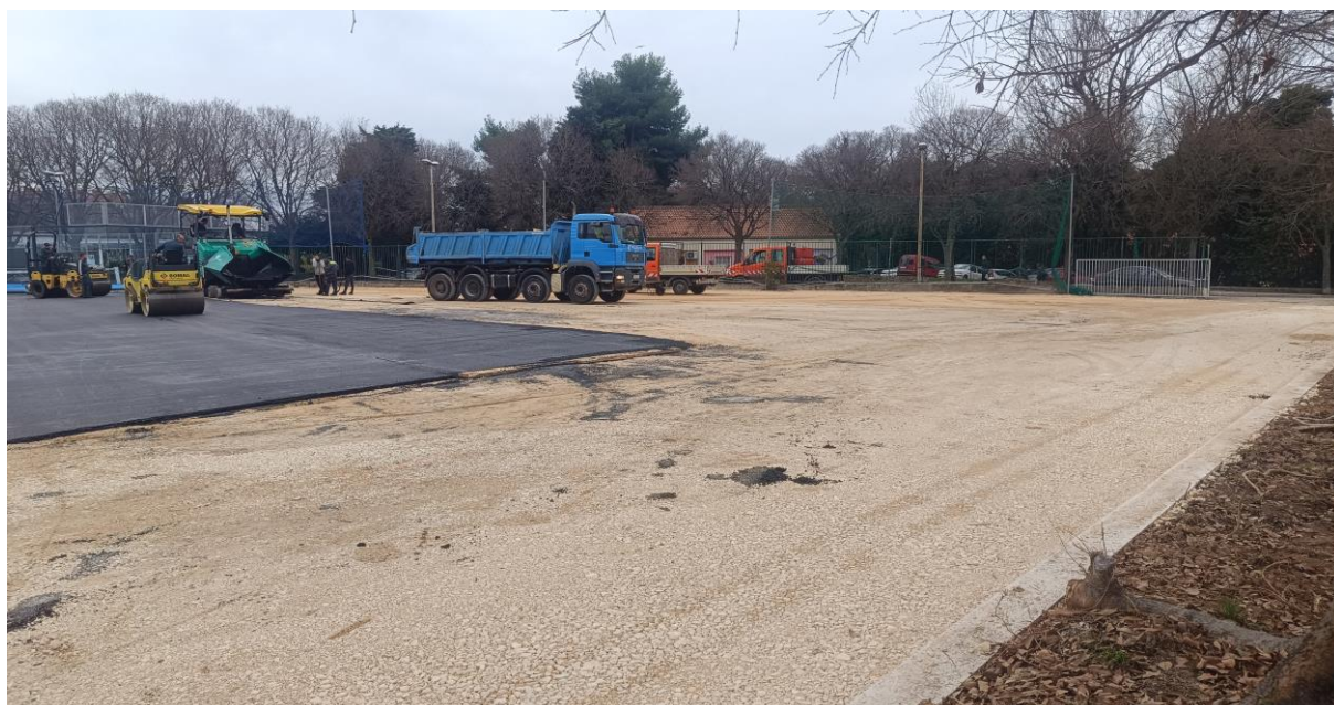
Slika broj 10: Pripremni i zemljani radovi na vanjskim terenima ŠRC-a Ravnice (2)
