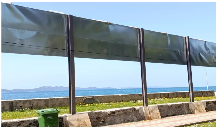
Slika broj 33: Sanirana čelična konstrukcija reklamnih panoa na Otvorenom plivalištu (2)
