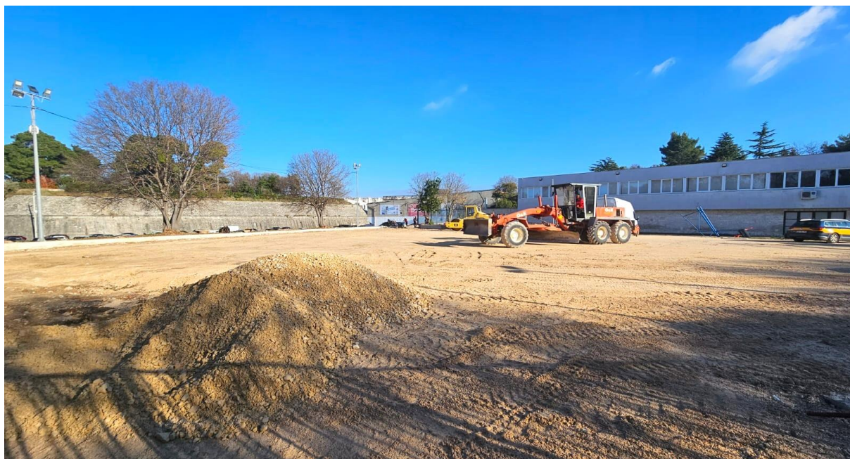
Slika broj 9: Pripremni i zemljani radovi na vanjskim terenima ŠRC-a Ravnice
