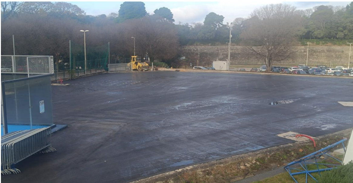
Slika broj 12: Asfalterski radovi na vanjskim terenima ŠRC-a Ravnice (2)
