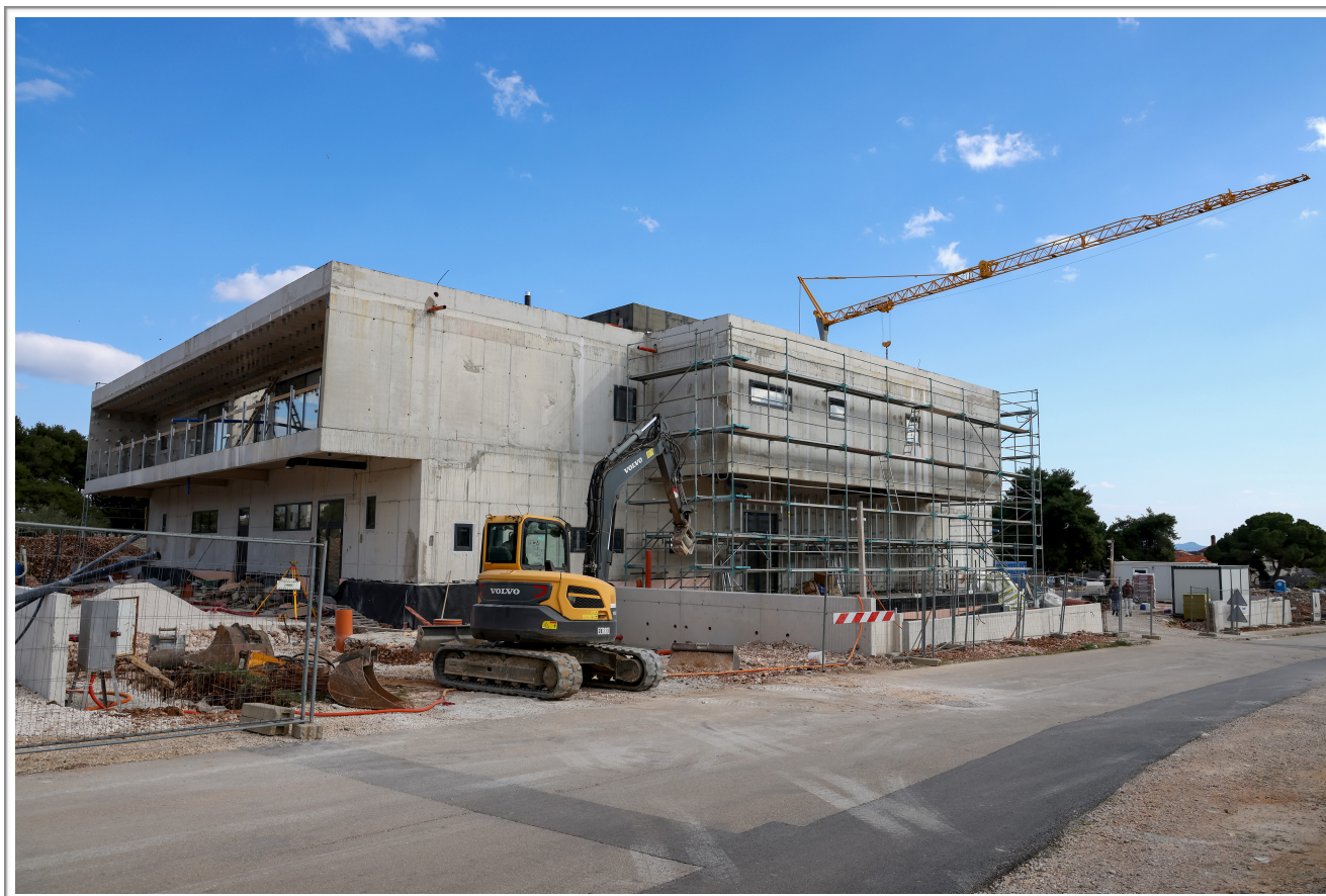
Slika 1: Izgradnja vrtića na Smiljevcu
