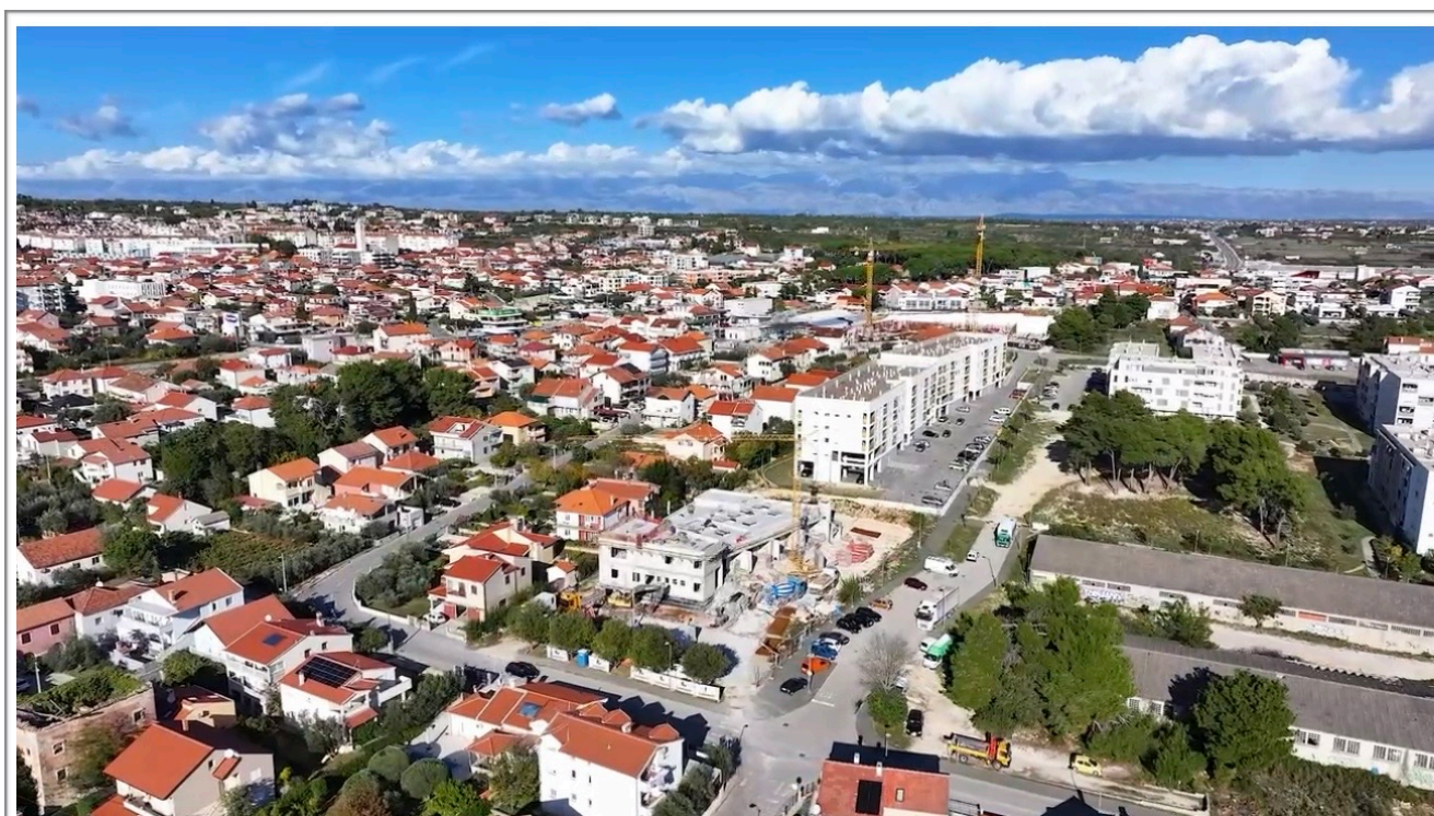
Slika 2: Izgradnja zgrade centralnih funkcija, u kojoj će, uz mjesni odbor i ambulantu, biti novi dječji vrtić
