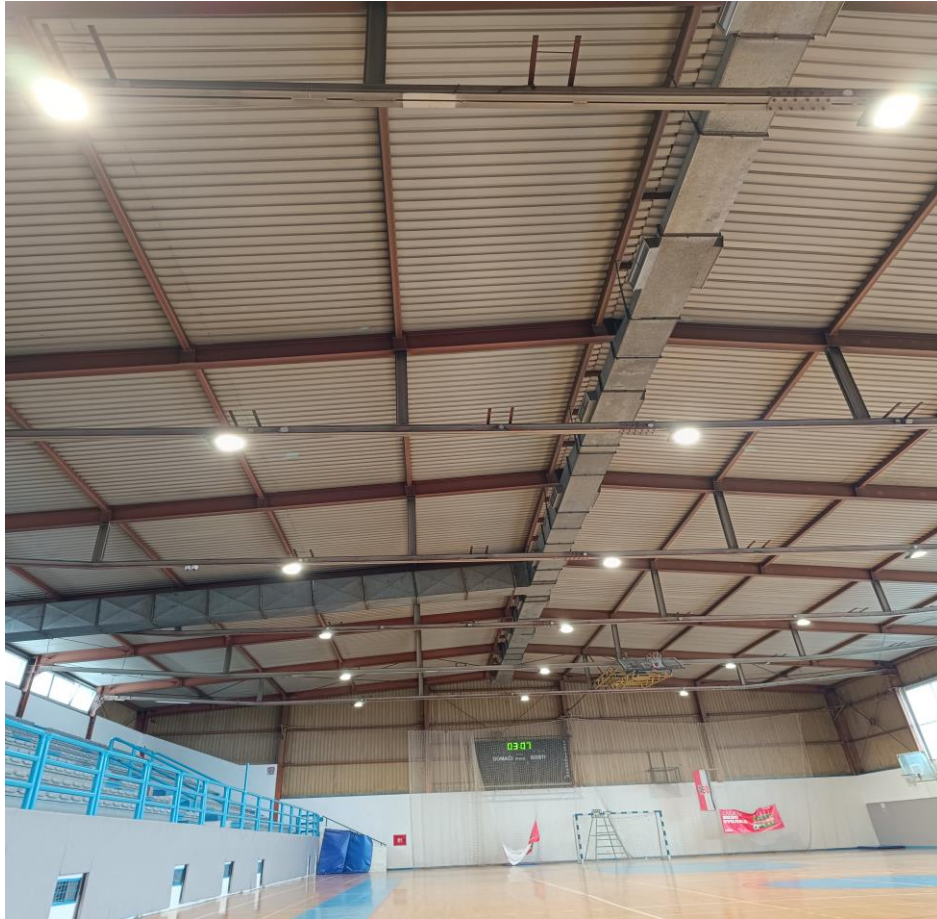
Slika br: 18 Postavljeni novi LED reflektori u dvorani Mocire
