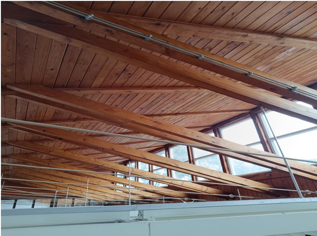
Slika br. 27 Sanacija i zaštita drvene krovne konstrukcije
