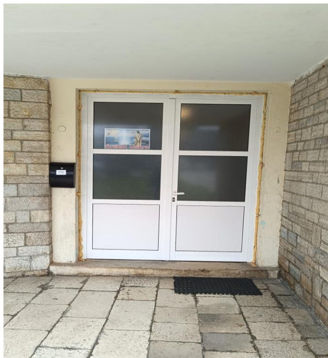
Slika br. 13 Zamijenjena vrata na glavnom ulazu objekta
