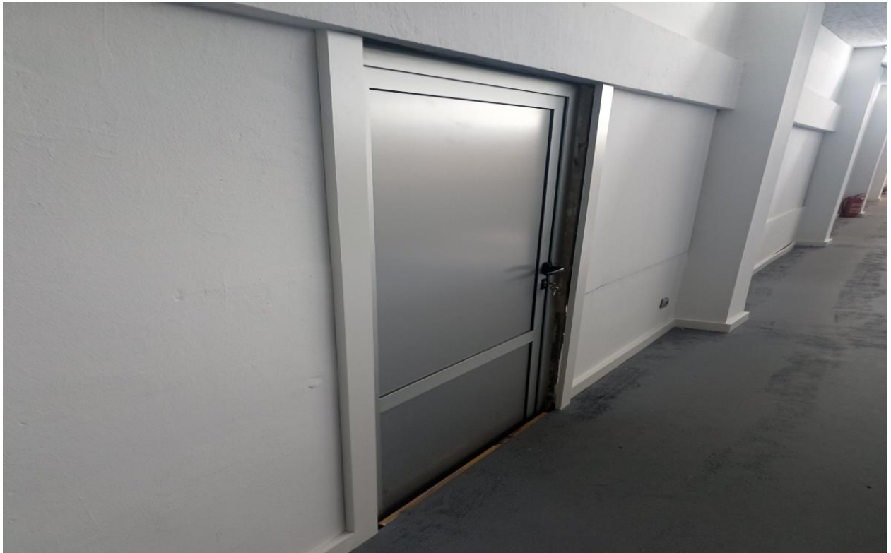
Slika br. 28 Postavljeni dovratnici od bijelog iverala u sklopu ŠRC Mocire
