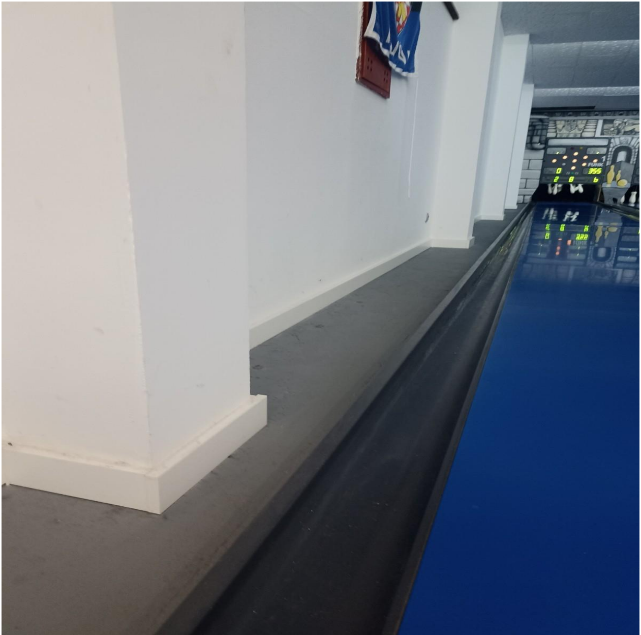
Slika br. 27 Postavljene cokle u kuglani
