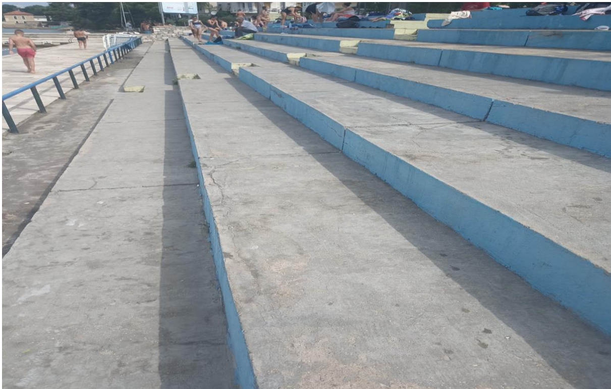
Slika br. 33 Stepenište tribina na Otvorenom plivalištu Kolovare
