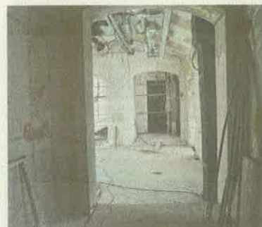
Postavljaju se instalacije
