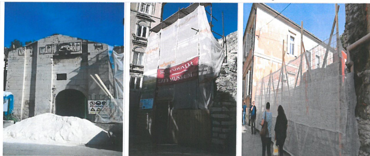
Slika 9: Radovi na obnovi Malog arsenala, Vratima Sv. Krševana, prolazu cara Augusta
